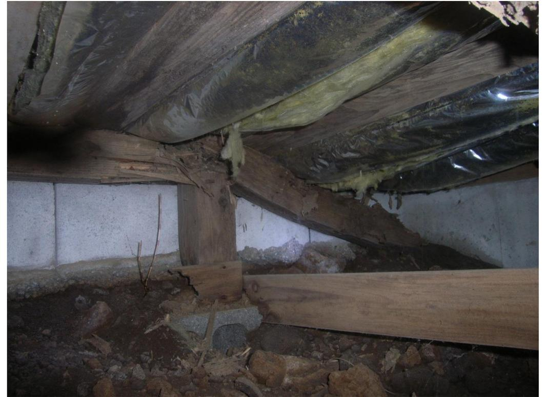
調査時に発見したシロアリの被害や、シロアリの通り道である蟻道を発見した場合、家屋のどの位置で、どれほどの被害であるのか、デジタルカメラをテレビに接続してすぐに見ていただくことができます。
