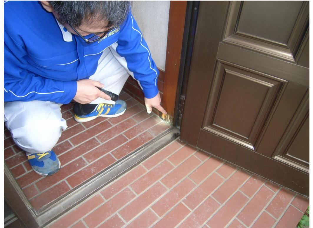
調査は非破壊検査ですと、壁内の状態がわかりませんが、柱のあるべき箇所を叩くと軽い音であったり、空洞音がすると、壁内の柱にシロアリの喰害があります。
