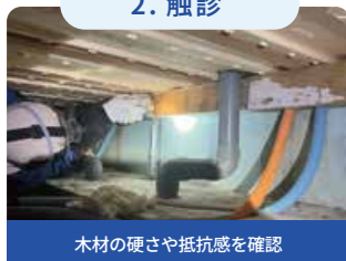
変色、菌糸、雨漏り・漏水跡を確認
